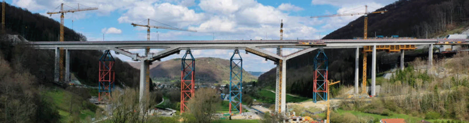
Mühlhausen im Täle, Filstalbrücke
